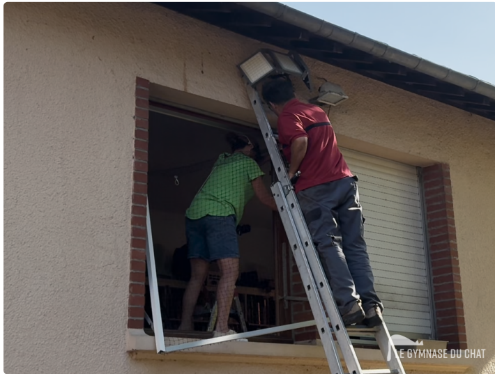
Installation d'un filet "spécial chat". Spéciale chat ça veut dire que le filet a une âme en métal qui résiste aux dents et griffes.
